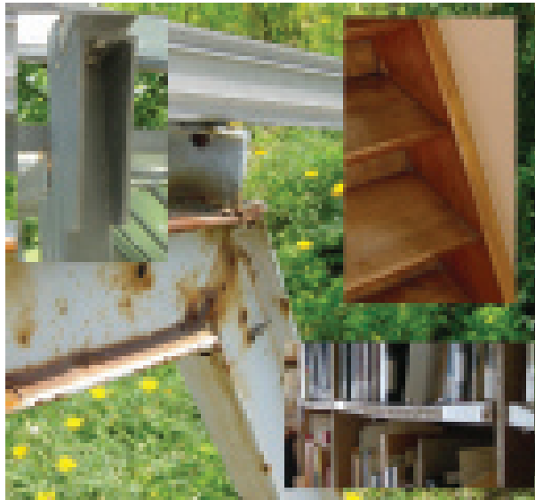
Abb. 7: Stahlträger (unter einem Glasdach) für Biegebela- stung: Material sitzt dort, wo die größten Druck- und Zug- spannungen auftreten, also außen. Das »Hochformat« (oben links und rechts) ist sehr viel stabiler als das »Querformat« (rechts unten: Der Querschnitt des Regalbretts ist ca. halb so groß wie der des Treppenseitenteils, Letzteres trägt aber die zehnfache Last ohne merkliche Biegung!)
