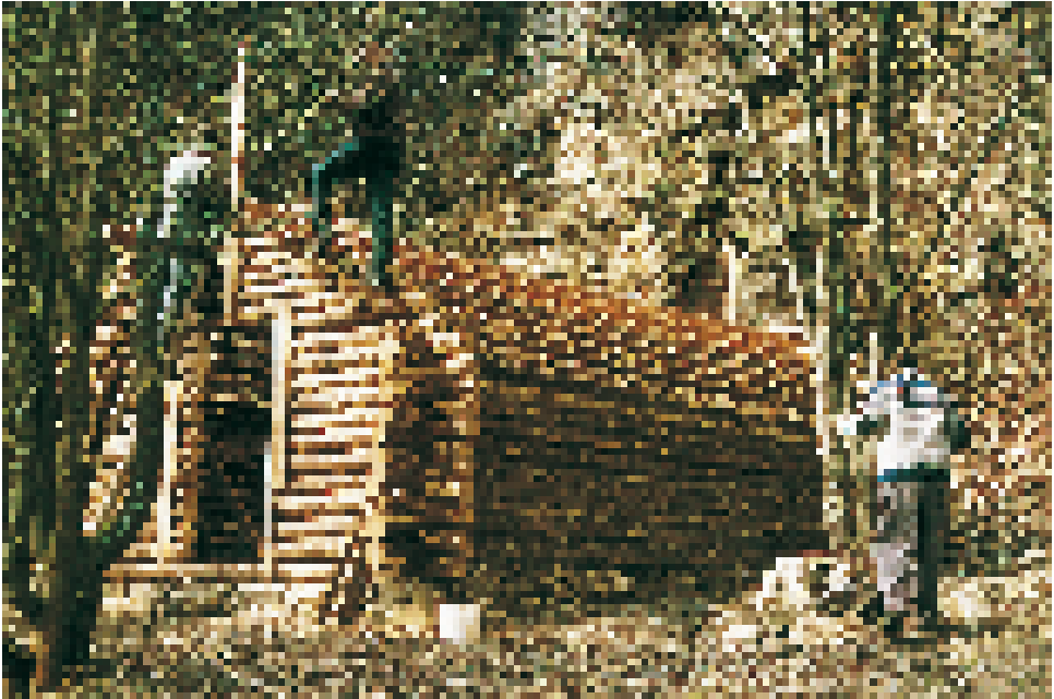
Oben: Unsere russisch-karelische Blockhütte wächst: eine Konstruktion aus gerepelten Balken, mit Lehm abgedichtet, darüber ein Bretterdach mit Rauchloch; im Innern ein runder Steinherd mit erhöhten Sitzflächen darum. Unten: Die Hütte ist fertig.
