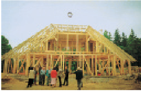
Im September 1999 wurde das Richtfest für das Fachwerkhaus gefeiert
