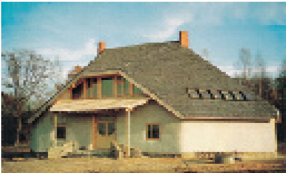
Das fertige Schulhaus in Renceni (kurz vor der Einweihung im Herbst 2000): im Erdgeschoss gibt es drei Klassenräume und einen Saal
