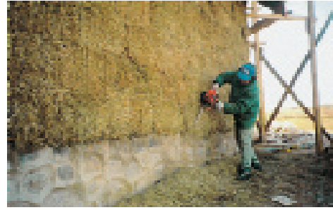
Die Fächer wurden mit Strohballen verfüllt und innen und außen verputzt
